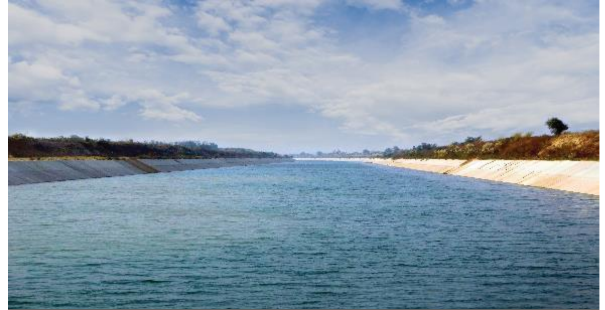
PLGC Canal, Uttar Pradesh
