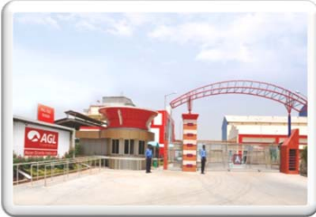
AGL Dalpur Plant (Wall Tiles)
