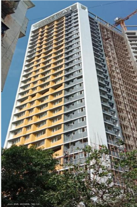
Tenant Building Ave Maria
