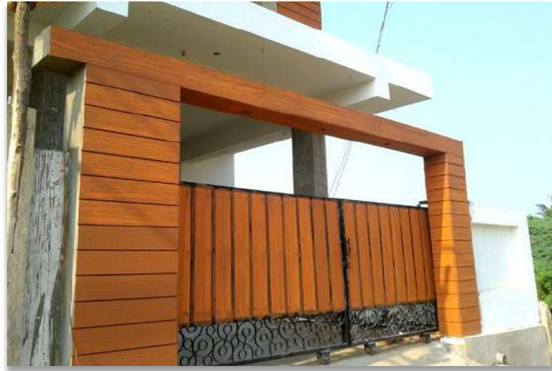
Gate Cladding - (V-Plank)
