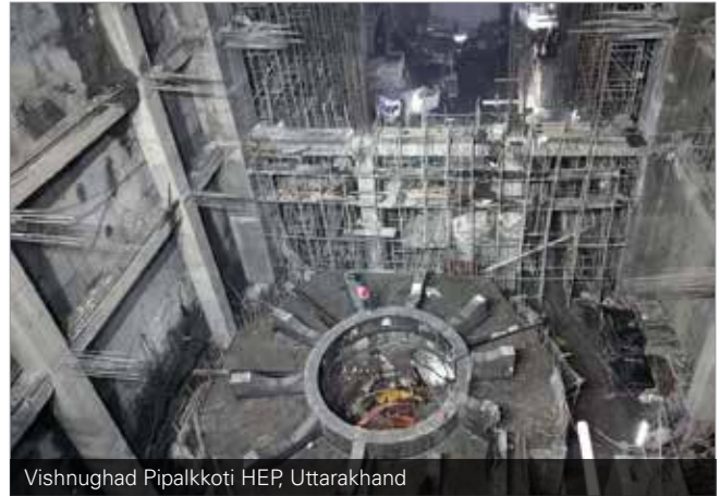
Vishnughad Pipalkoti HEP, Uttarakhand
