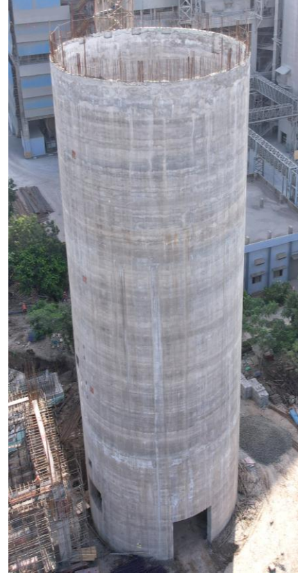
Fly Ash Silo
