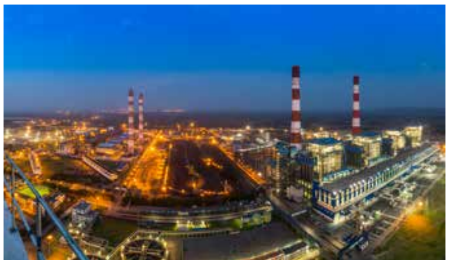
> 3400 MW OP Jindal Super Thermal Power Plant, Tamnar, Chhattisgarh
