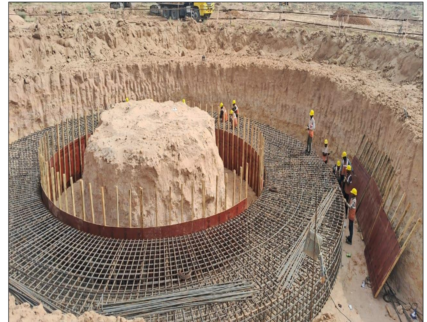
Fly Ash Silo
