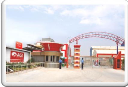
AGL Dalpur Plant (Wall Tiles)
