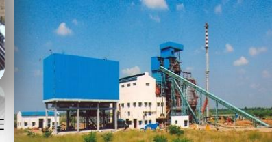
10 MW POWER PLANT FOR ETA POWERGEN
