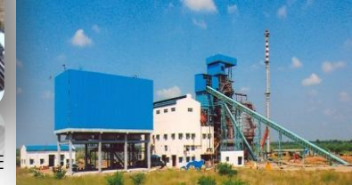
10 MW POWER PLANT FOR ETA POWERGEN
