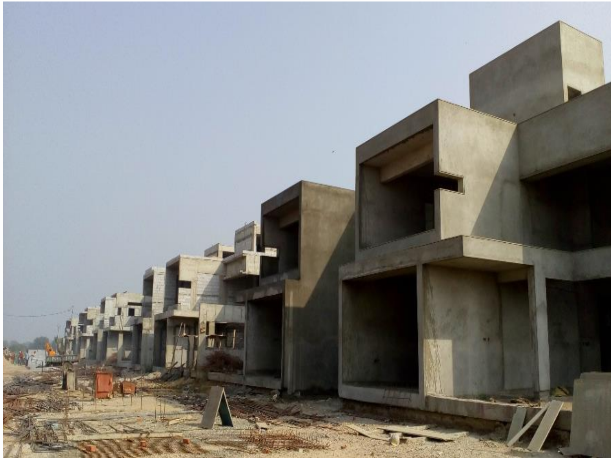
Actual Villa Construction
