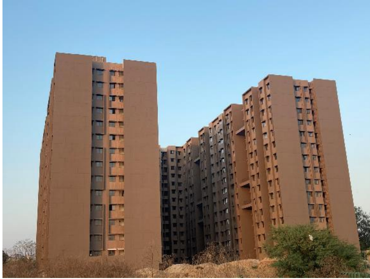
Actual Construction Images
