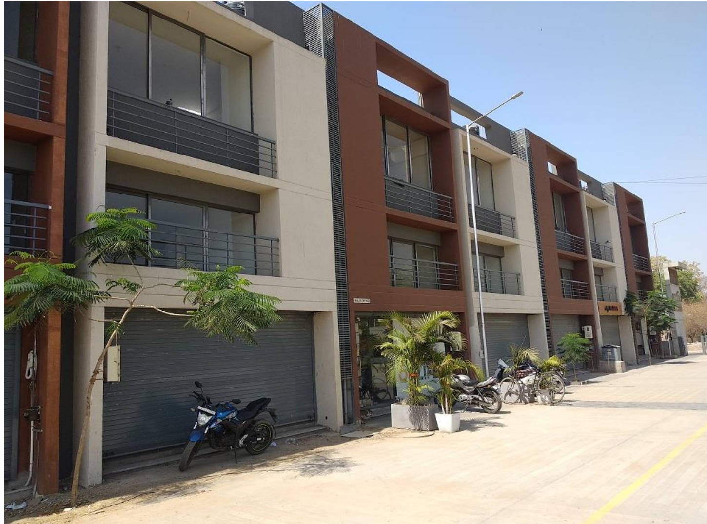
Actual Site Images – Shed Construction
