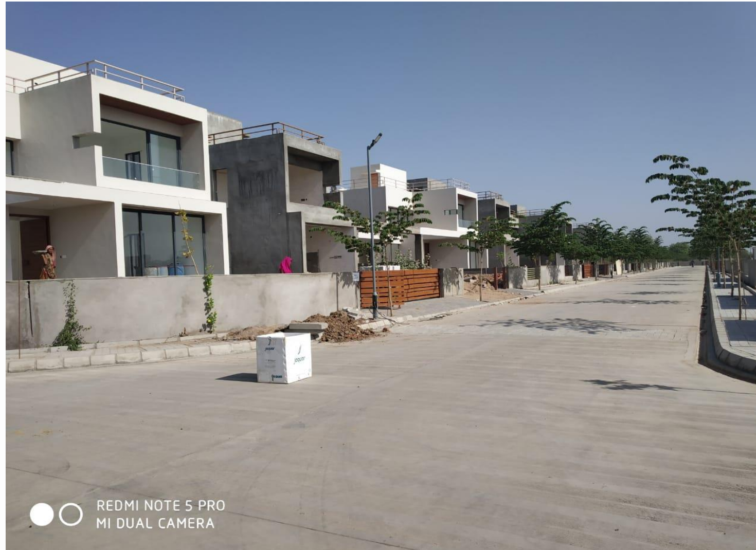
Actual Villa Construction
