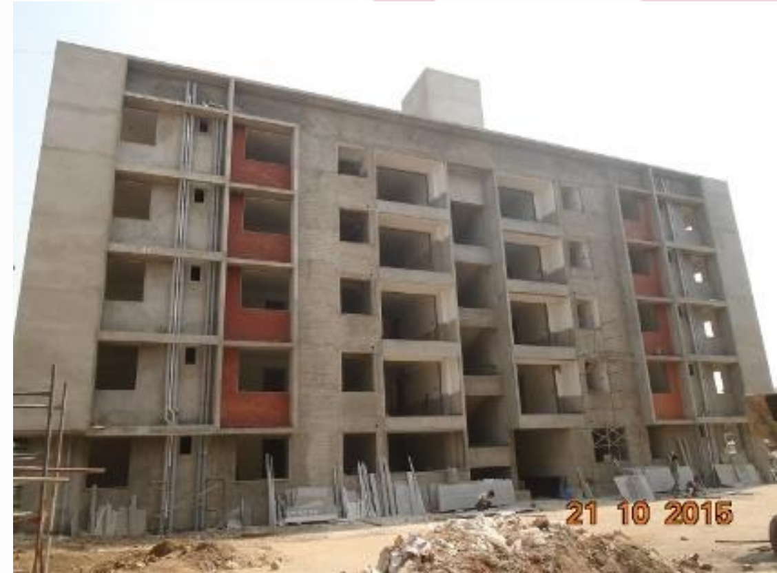
Block C Actual Construction
