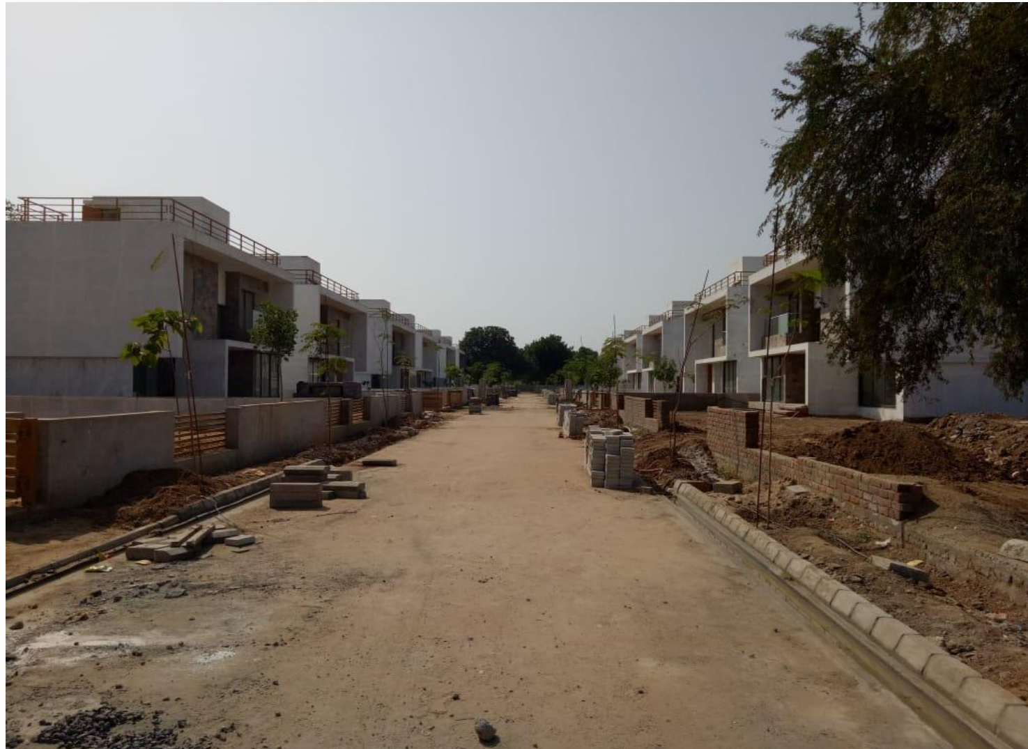
Actual Villa Construction
