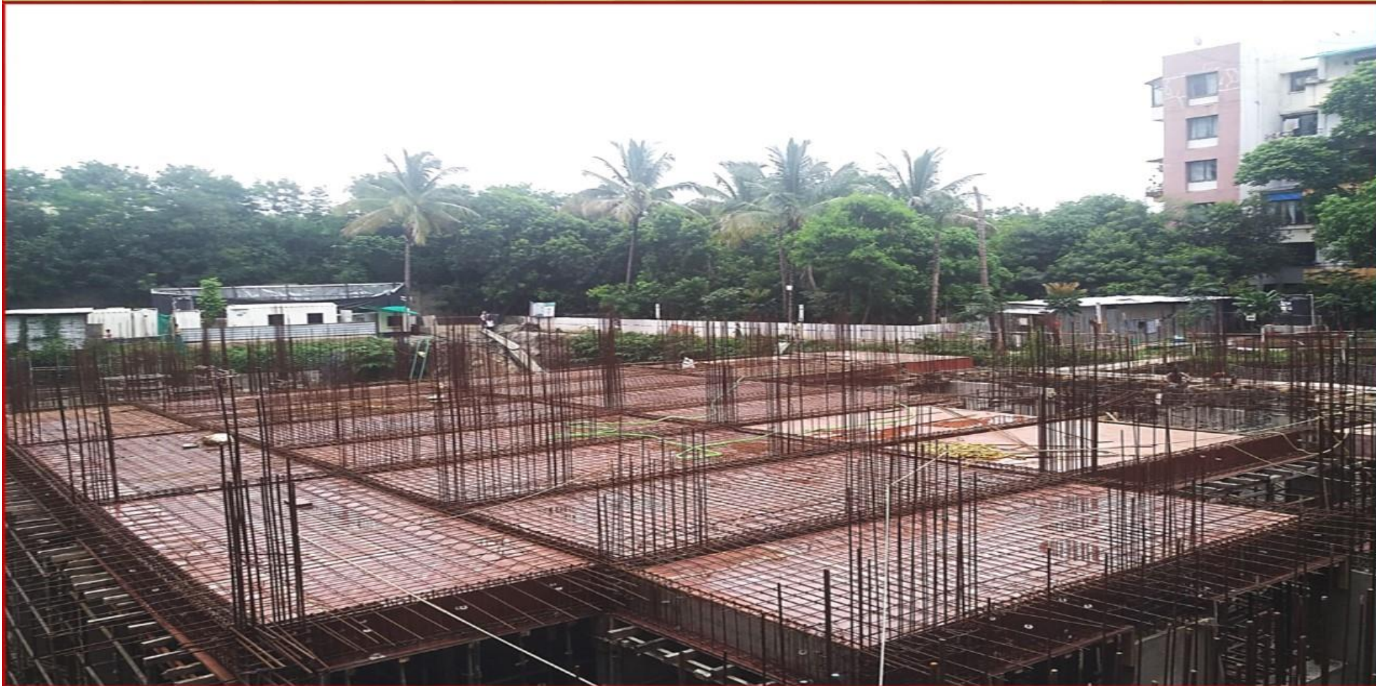
Actual Construction Image
