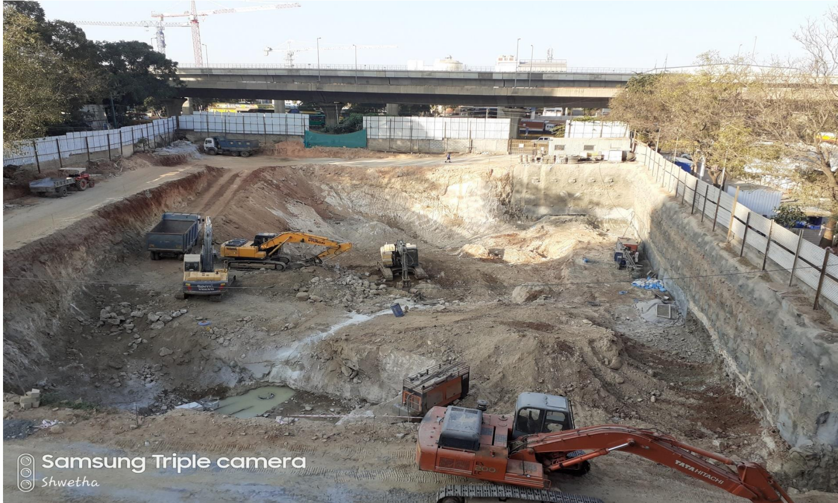
Actual Construction Image
