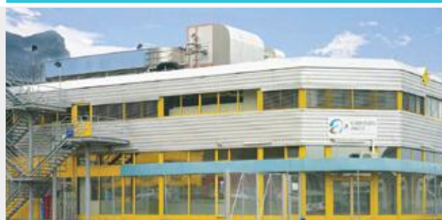
CARBOGEN AMCIS AG, Site Vionnaz, Switzerland
