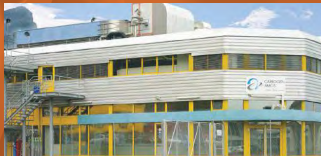
CARBOGEN AMCIS AG, Site - Vionnaz, Switzerland
